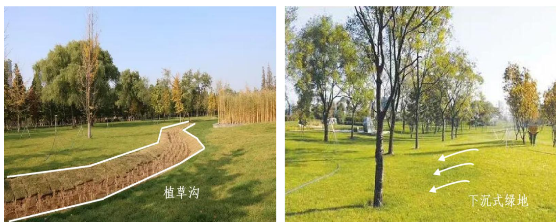
图 7 园区绿地雨水渗透系统实景图
