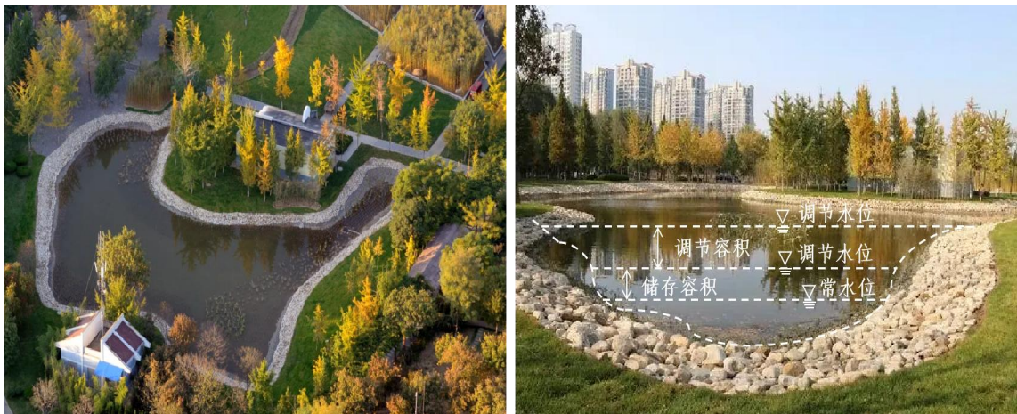
图 4 南部园区雨水集中式收集系统
